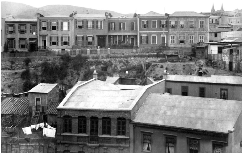
Muros cortafuegos, c. 1880. Se ven claramente entre las casas del paseo Atkinson, en el borde del cerro Concepción el fondo de la foto, pero también en los edificios del primer plano. Fotografía Félix LeBlanc, “Cerro Concepción, Valparaíso”, en Leblanc, op. cit.
