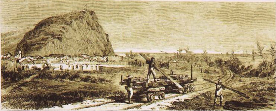
Figura 18: Arica antes del tsunami .
