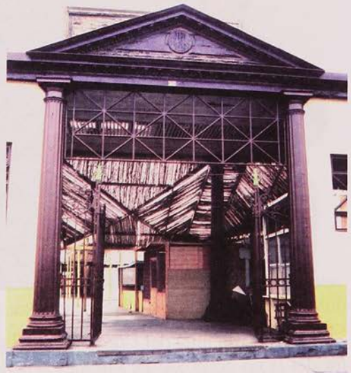
Figura 79: Columnas de la vieja aduana Bellhouse recicladas en el Mercado de Arica.
