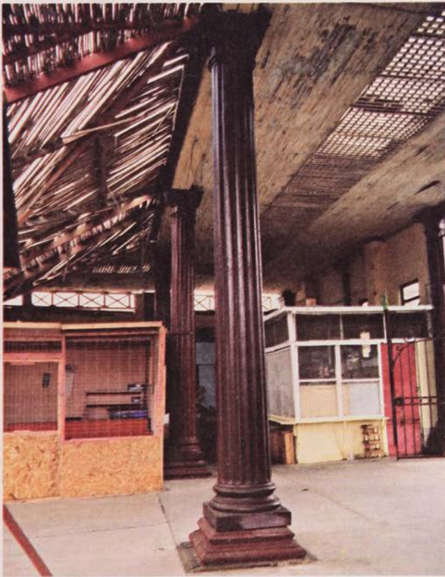
Figura 80: Columnas Bellhouse en el interior del Mercado de Arica. 2005.
